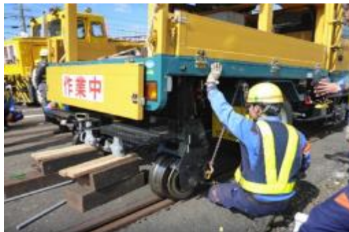
架線車の脱線復旧訓練
