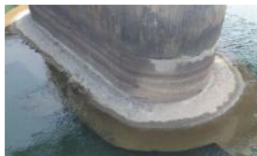
補強工事前の橋脚
