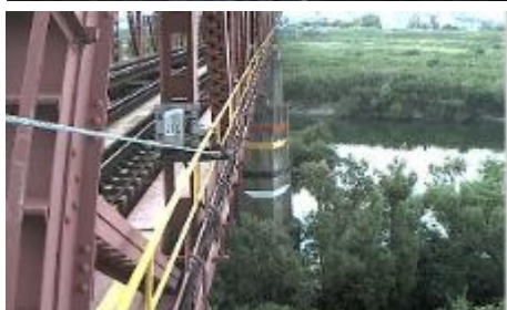
河川監視カメラ(上)とその映像(下)
