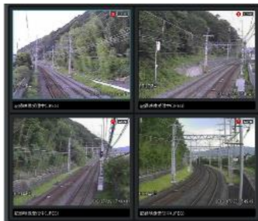
急傾斜法面監視カメラの映像
