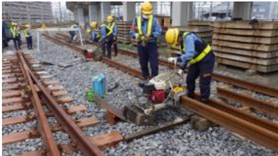
軌道の保守作業実務研修
