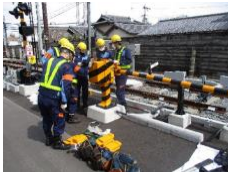
踏切保安装置の復旧訓練
