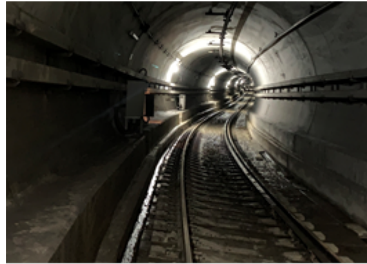
復旧後の様子
