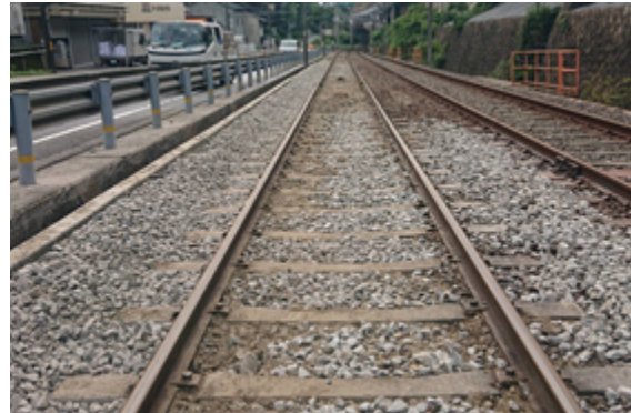
復旧後の様子
