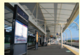
膜構造を採用したホーム屋根
