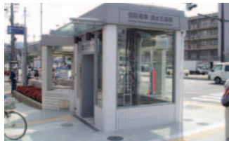
エレベーター(清水五条駅)
