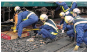
車両係員による脱線復旧作業
