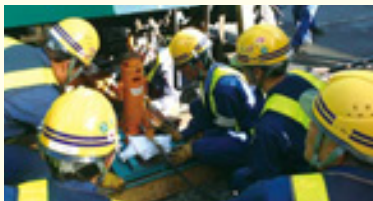
▲車両係員による脱線復旧作業
