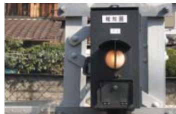
作業用列車接近報知器
