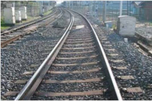
脱線防止ガードレール
