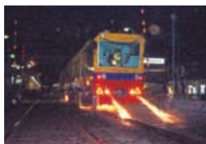
レール削正作業
