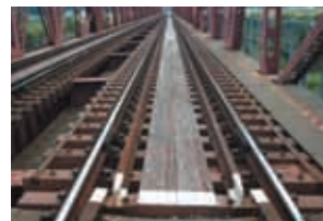
橋上ガードレール
