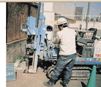
▲自走式ボーリングマシンによる土壌試料採取(かんこう)
