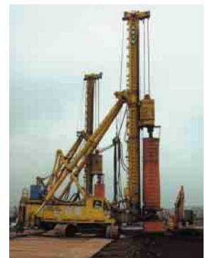
▲鉄粉法による浄化作業
